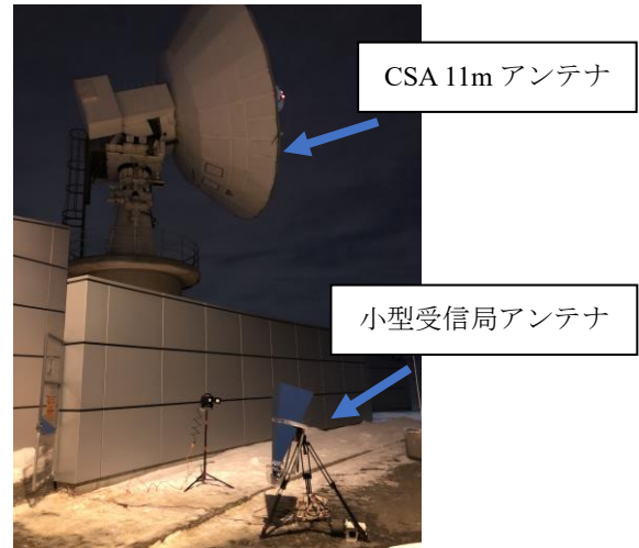
(a)アンテナ設置状況 (11m アンテナとの位置関係)
